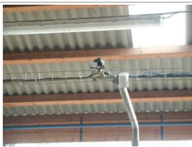
Obr. 10 Tryska a infračidlo
