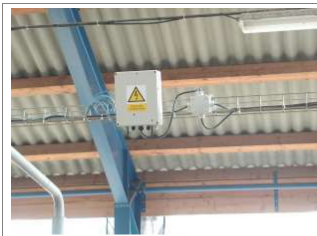
Obr. 9 Umístění řídicí jednotky
