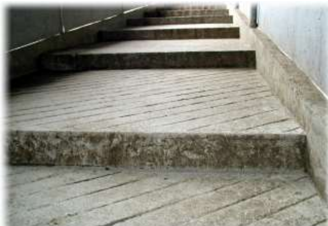
Rozdílné úrovně mezi stájí a dojárnou řeší schody
