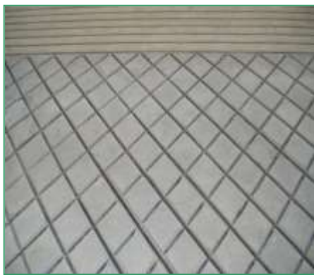
Diagonální a „stroměčková“ profilace podlahy průchodu
