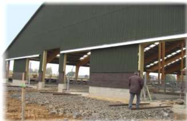
Do podlah se vkládají ochranné vodící lišty
