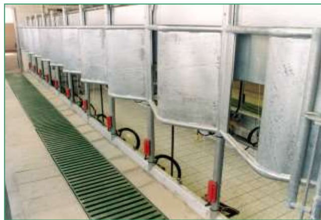
Nevhodné řešení, kdy dojnice stojí na roštu
