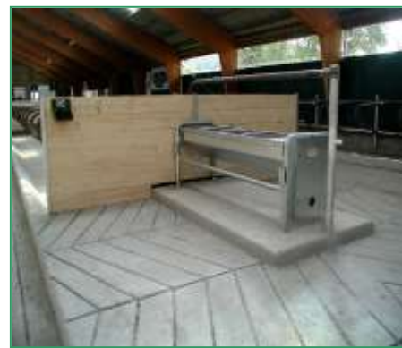
Diagonální a „stroměčková“ profilace podlahy průchodu
