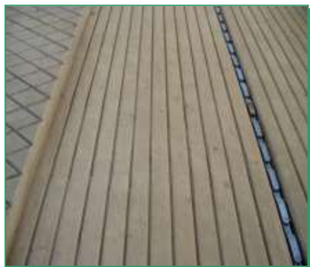
Podélná profilace hnojné chodby
