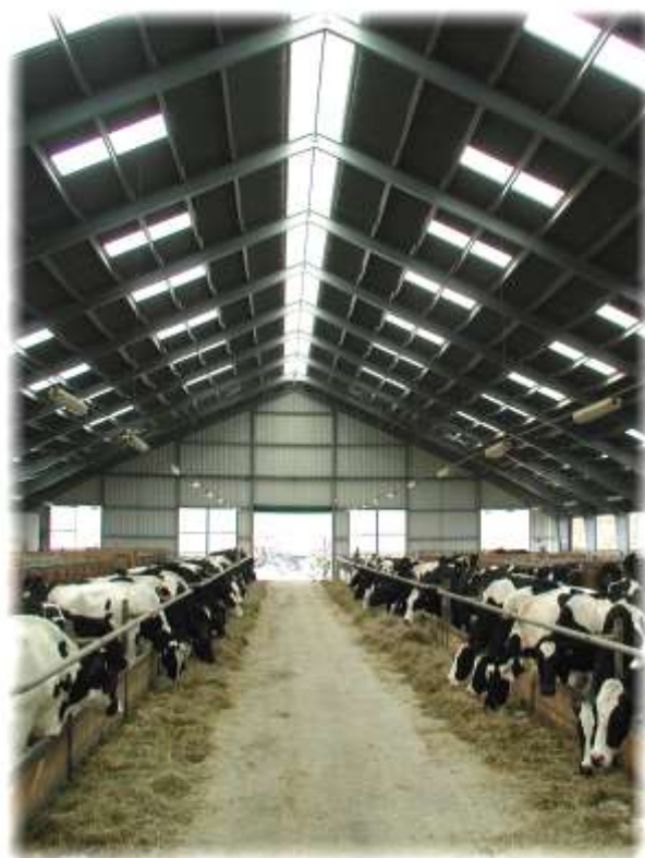
Osvětlení stáje výrazně přispívá ke komfortu ustájení
