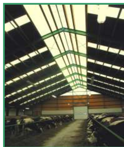
Žluté prosvětlení je nevhodné. Extrémní prosvětlení v oblasti hřebenové štěrbině vede k přehřívání prostoru krmného stolu.
