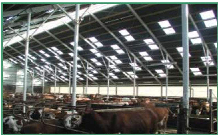
Optimální „cik-cak“ rozmístění prosvětlovacích oken.
