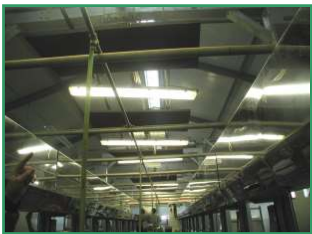
Zářivková tělesa jsou umístěna příliš vysoko. V pracovním prostoru stíní konstrukce stavby.
