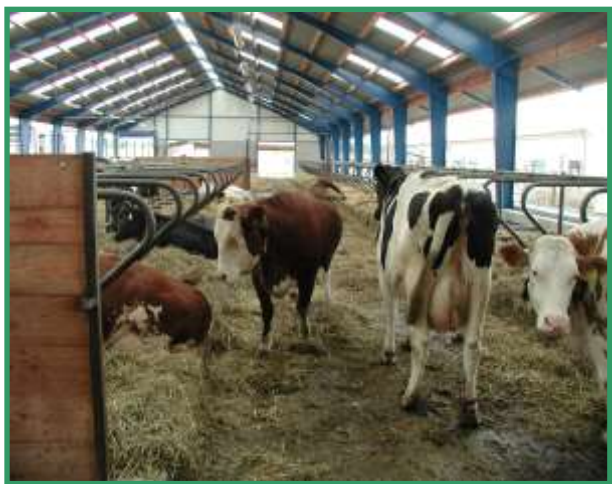
V produkční stáji VÚŽV na farmě v Netlukách je optimální distribuce světla. Boční ventilační plachty propouštějí dostatek světla. Střeška je prosvětlena bezbarvými průsvitnými deskami v ploše 1/10 půdorysu stavby.
