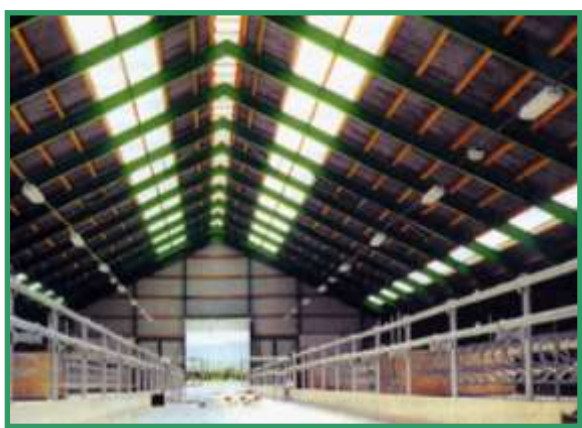
Horizontálně řazená prosvětlovací okna způsobují místní přehřívání ploch, především žlabového tělesa a řady boxových loží.
