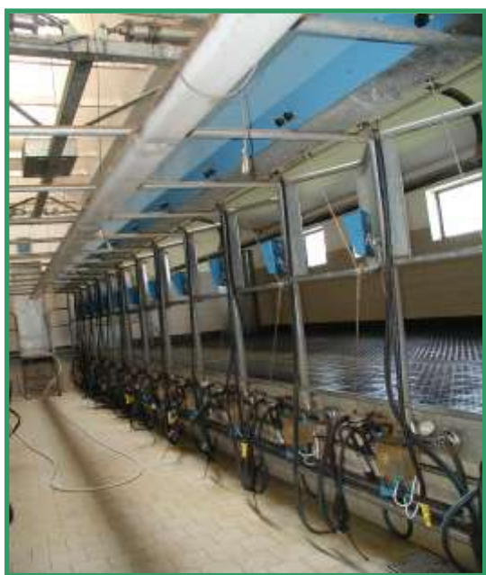
Optimální situování řady zářivkových těles nad pracovním polem dojiče
