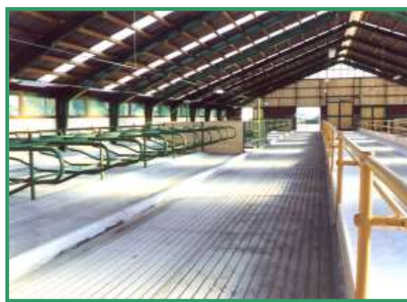
Vertikálně řazená prosvětlovací okna místní přehřívání ploch eliminují, distribuce světla je rozptýlená.
